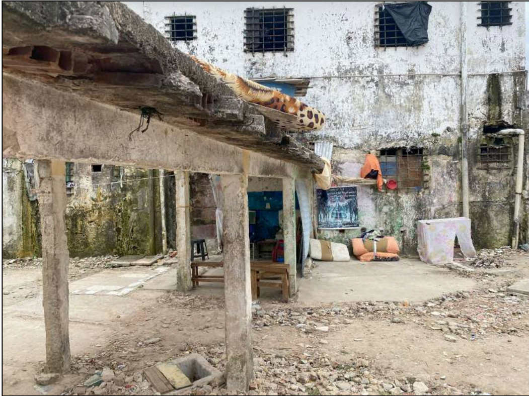
Figuras 78 a 80: área externa de pavilhão (acima), corredor de pavilhão (esq.) e cela (dir.)
