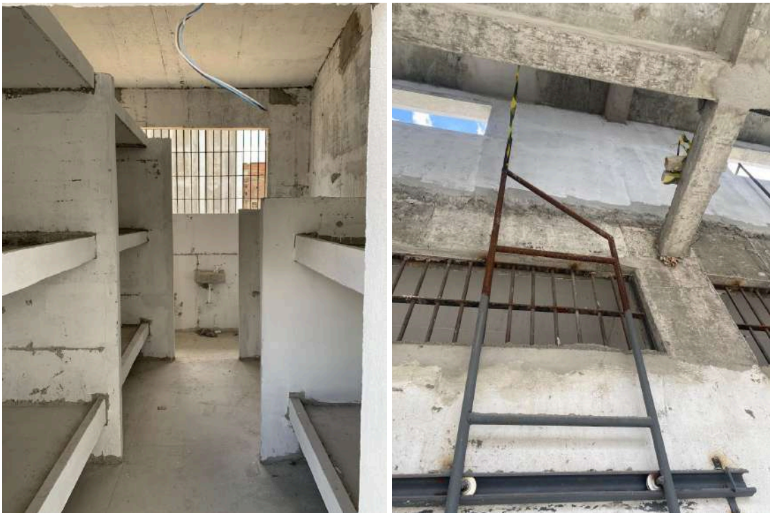
Figuras 180 e 181: Obras de ampliação
