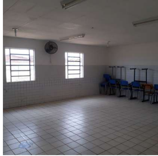
Foto 26: Vista 2 do interior de uma das salas de aula - E. M. Aureliano Francisco Neto.
