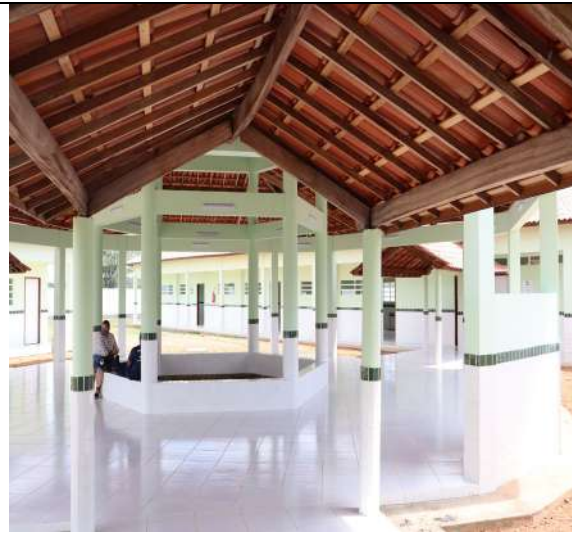
Foto 17: Vista do pátio do prédio novo da E. M. Dr. Nilo de S. Coelho.
