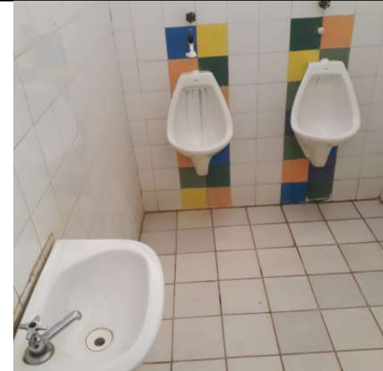
Foto 4: Banheiro masculino da Creche anexa a E. M. Aureliano F. Neto.
