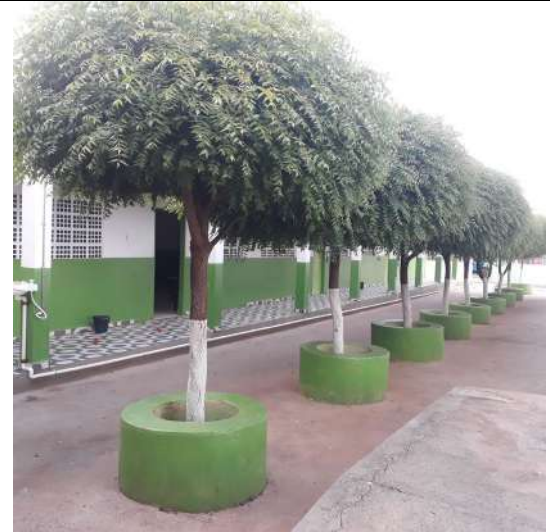
Foto 44: Vista do corredor externo de salas de aula.
