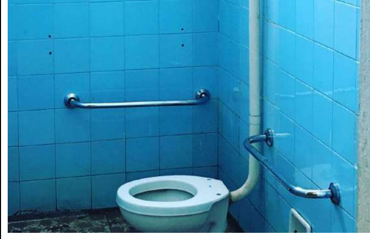
Foto 9: Vista do interior de um dos banheiros da extensão da E. M Mundo Infantil.
