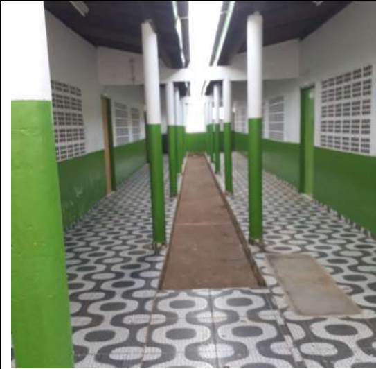
Foto 43: Vista do corredor interno de salas de aula.
