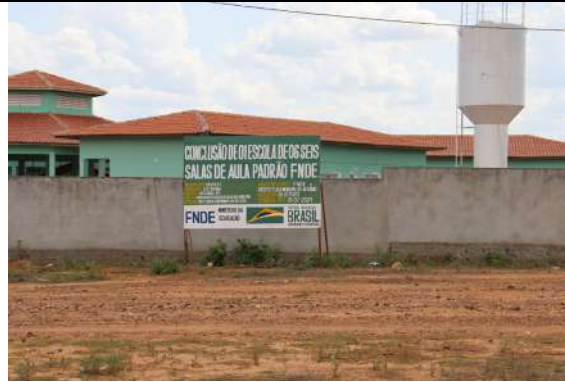
Foto 32: Vista da nova escola E. M. Aureliano F. Neto.
