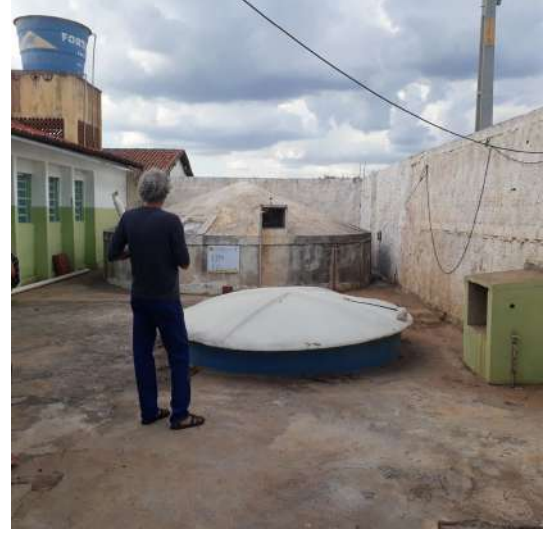
Foto 45: Vista dos reservatórios de água.
