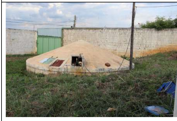
Foto 34: Vista do reservatório d'água.
