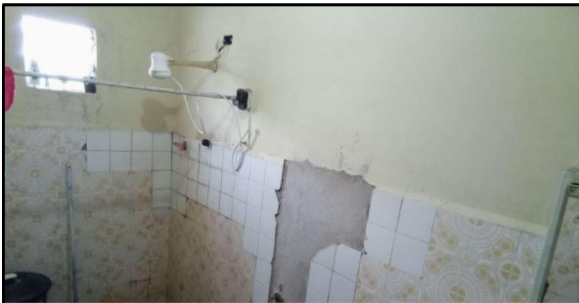
Figura 70: Sanitário do alojamento do 2º BPM.
