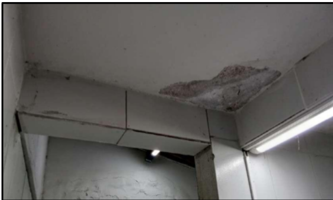
Figura 69: Sanitário do alojamento do 26º BPM.
