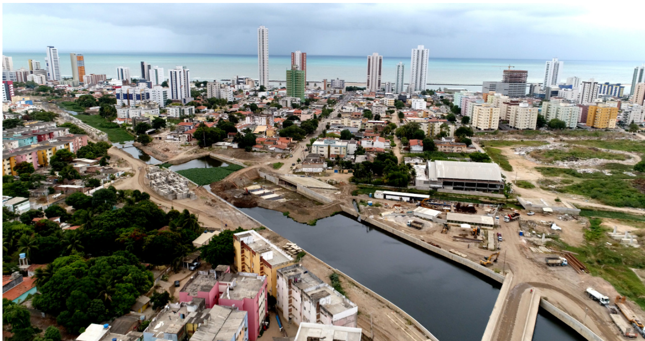
TCE “alerta” CEHAB para a conclusão das obras do Canal do Frágoso
